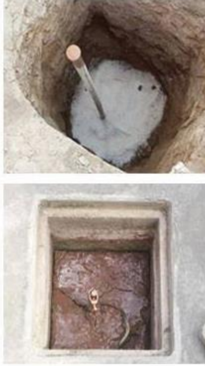
شكل رقم ٢٩: حفرة التأريض
